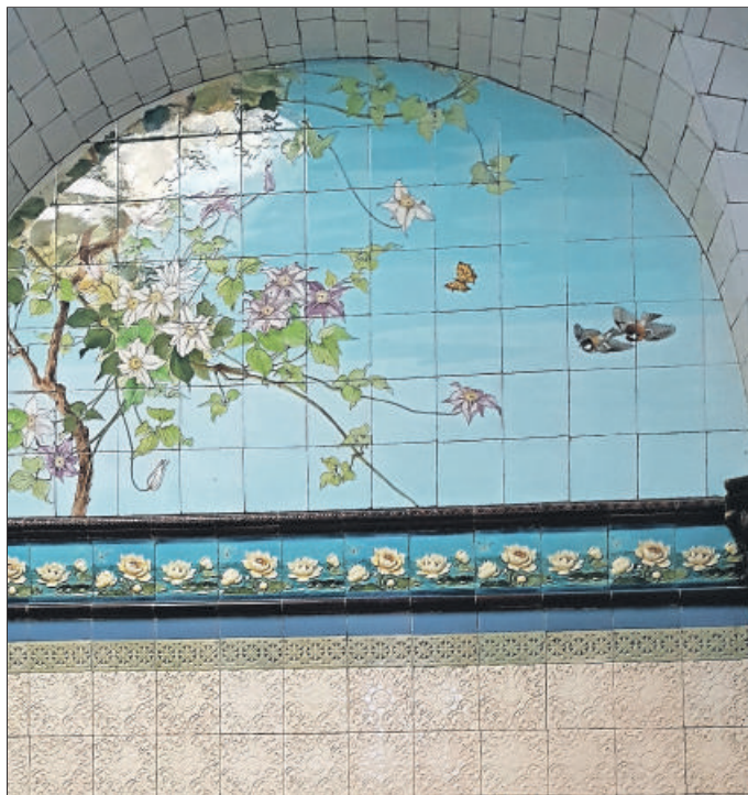
Die Heißluft läuft auch während der Schließzeit, um den historischen Fliesenspiegel zu schützen.
